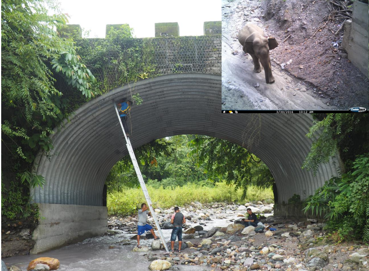
ส่วนสำคัญ ทางลอดของสัตว์ป่าที่ออกแบบมาสำหรับทางช้างเผือกเป็นหลักฐานถนน NH2 (Raidak- Lhamoizingkha) ในภูฏาน เครดิตแก่ Karma Chogyel
