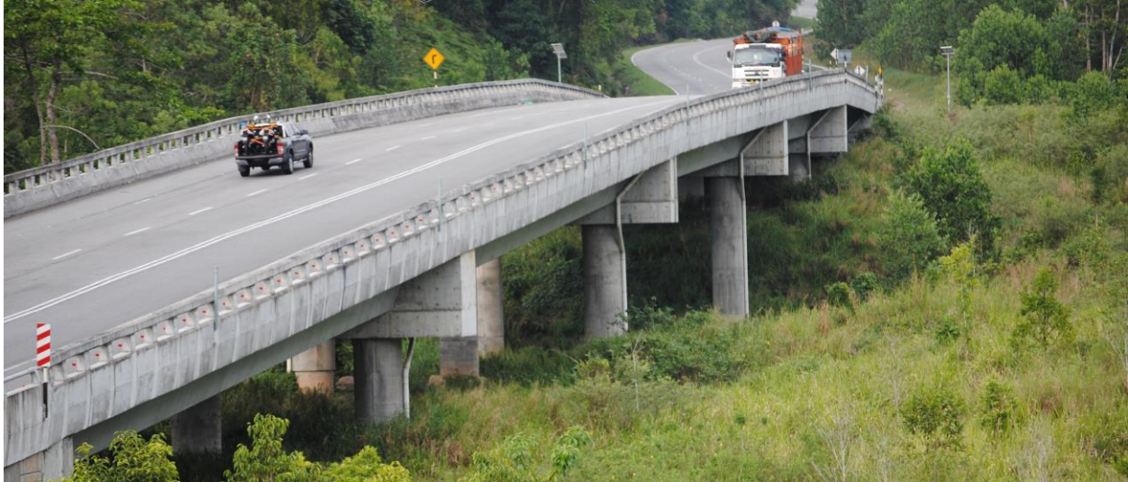
อุโมงค์ลอดสำหรับช้าง เสือ และสัตว์ป่าอื่น ๆ บนทางหลวง Jeli-Gerik ประเทศมาเลเซีย เครดิตแก่ Rob Ament
