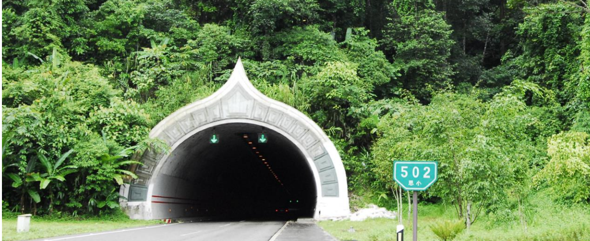
อุโมงค์บนทางด่วน Sixiao มณฑลยูนนาน ประเทศจีน เครดิตแก่ Rob Ament
