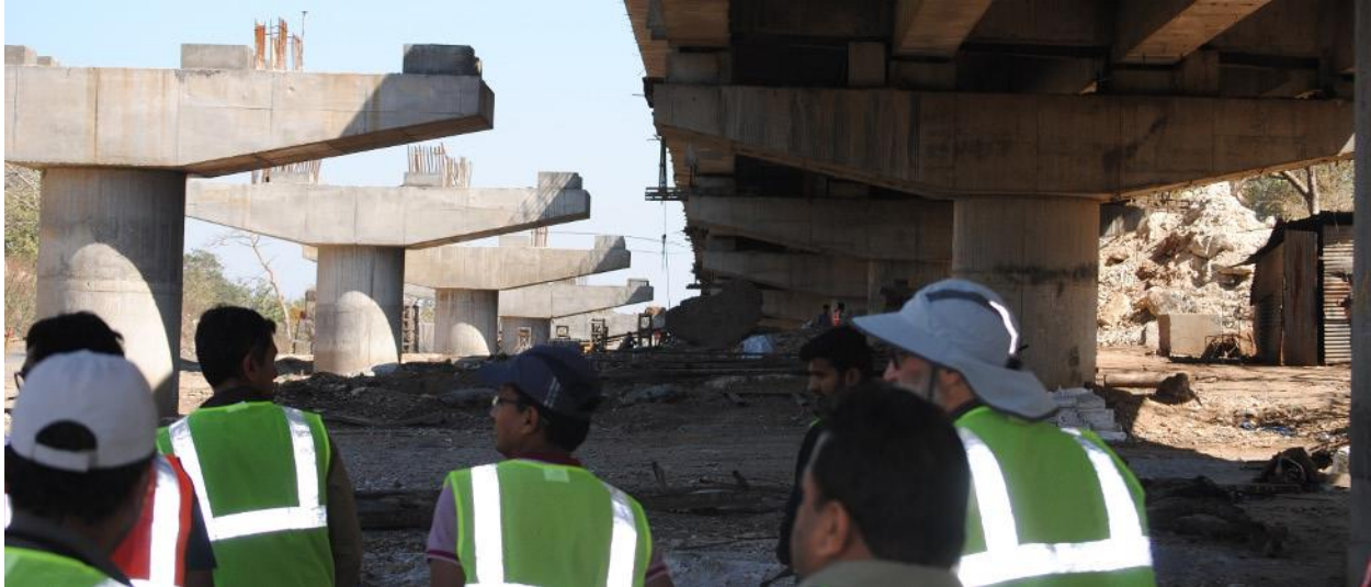
อุโมงค์สัตว์ป่าที่กำลังก่อสร้างบนทางหลวงแห่งชาติ (NH) 44 ในเมือง Maharashtra ประเทศอินเดีย เครดิตแก่ Rob Ament
