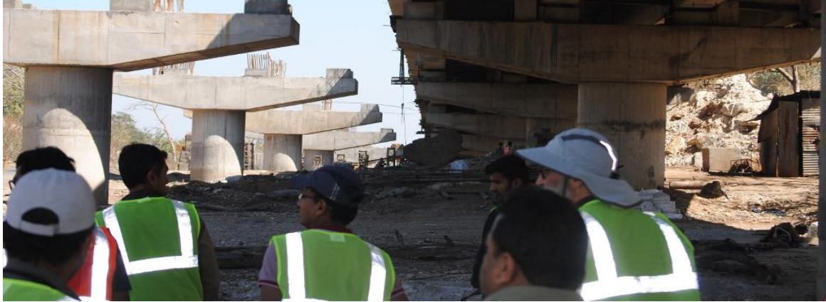
Строящийся подземный переход для диких животных на автомагистрали национального значения (АНЗ) 44 в Махараштре, Индия. Фото: Роб Амент
