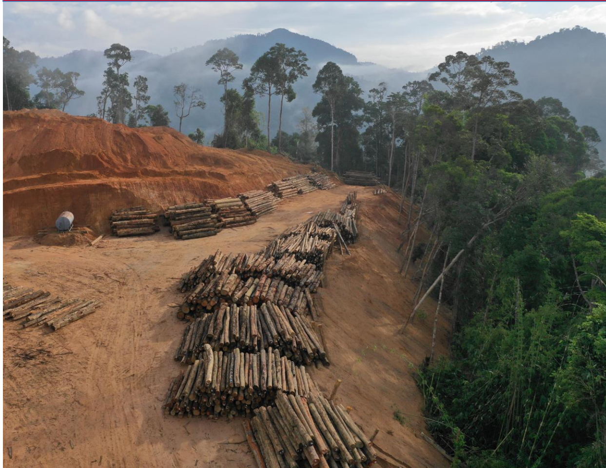
Вырубка леса в Малайзии во время строительства новой дороги.
