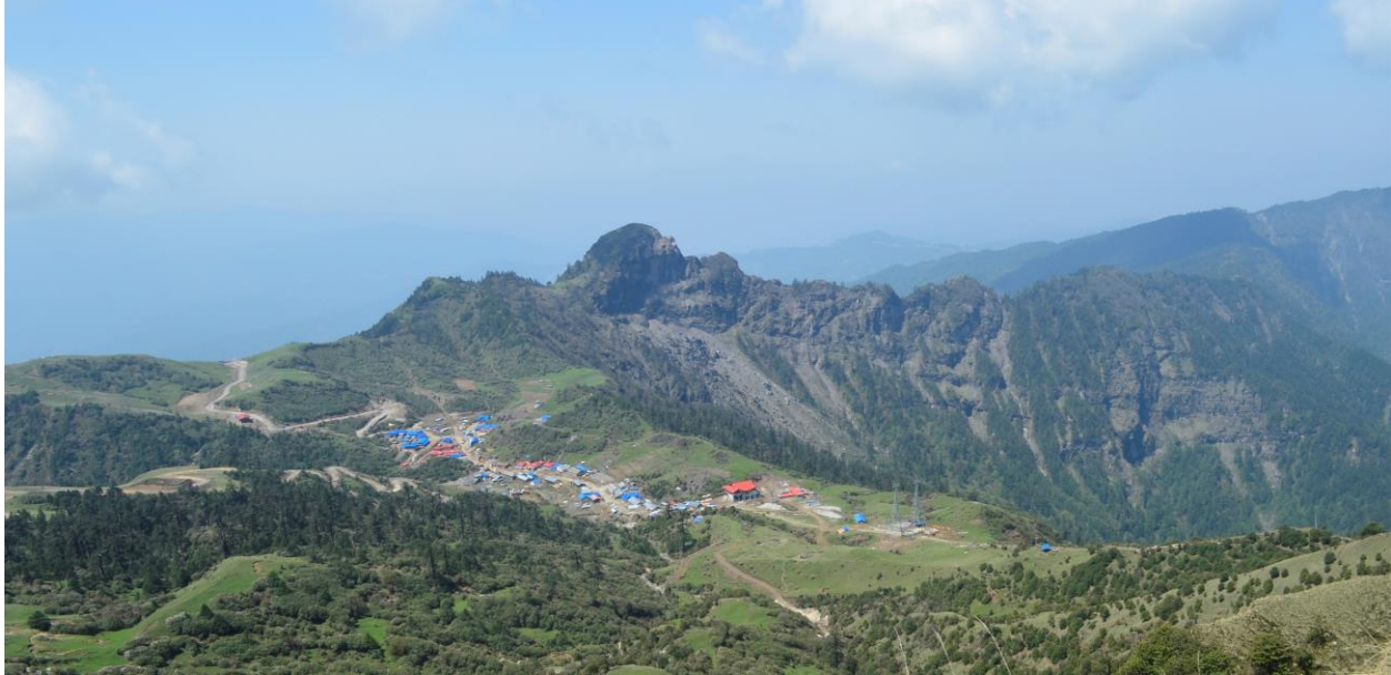
Развитие местной инфраструктуры в связи со строительством дороги в Калинчоке Долакхского района, Непал. Фото: Падам Б. Чанд
