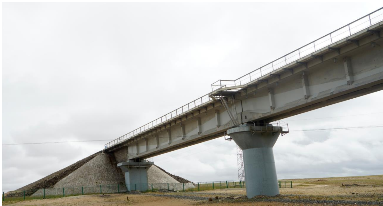
Подземный переход Вубэй позволяет тибетским антилопам проходить под железной дорогой на Тибетском нагорье в Китае. Фото: Вэньцзин Сюй
