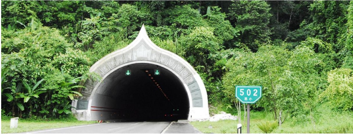
Туннель на скоростном шоссе Сисяо, провинция Юньнань, Китай. Фото: Роб Амент
