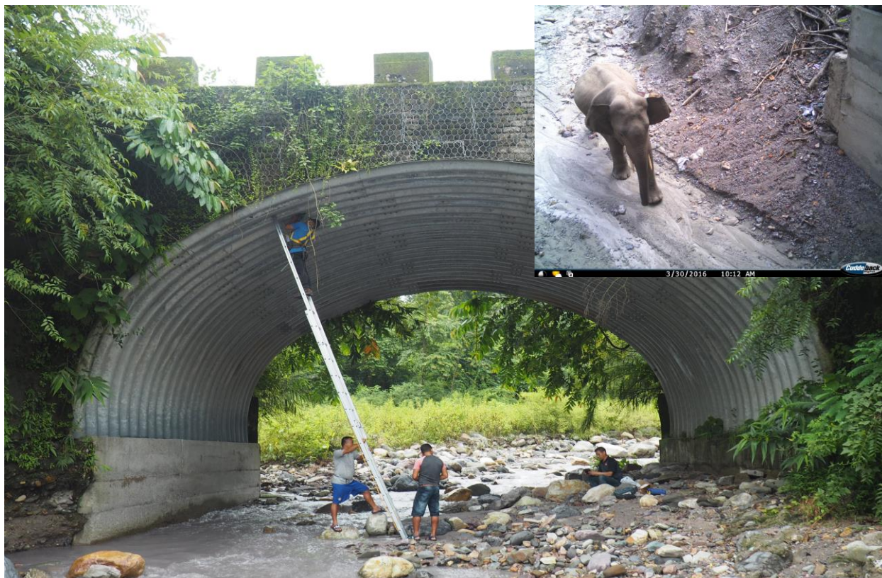
Үндсэн: Бутан дахь NH2 зам (Райдак-Лхамойзингха) дээр зааны гарцад зориулагдсан Зэрлэг ан амьтдын нүхэн гарц. Талархал: Карма Чогил
