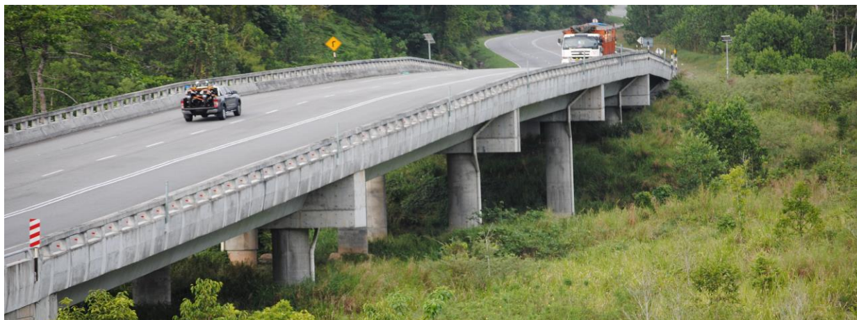
Малайзын Жели-Герик хурдны зам дээр заан, бар болон бусад зэрлэг ан амьтдад зориулсан нүхэн гарц. Талархал: Роб Амент
