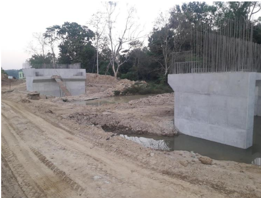
ภาพที่ 4 แสดงการก่อสร้างคานสำหรับทางลอดของสัตว์ป่า และจากนั้นจึงจะเจาะอุโมงค์ใน โครงการเส้นทางรถไฟสาย Chittagong – Cox's Bazar ขนาดสุดท้าย: สูง 4.5 ม. ยาว 30 ม. เครดิตแก่ Asif Imran
