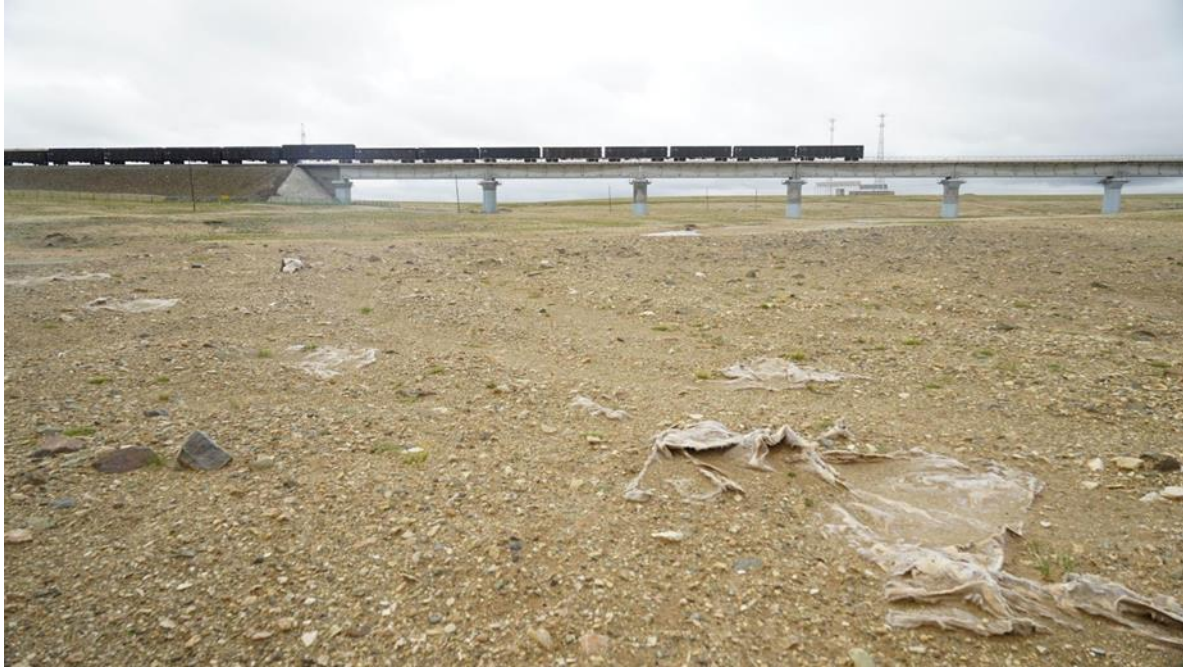
ภาพที่ 13 แสดงเส้นทางรถไฟสาย Qinghai-Tibet ในภาคกลางของจีน การอพยพทางไกลของละมั่งทิเบต ได้รับผลกระทบโดยตรงจากการสร้างเส้นทางรถไฟสาย Qinghai-Tibet โครงสร้างทางแยกหลัก 4 แห่งถูกสร้างขึ้นสำหรับพื้นที่ Hoh-Xi รวมถึงอุโมงค์ Wubei เครดิตแก่ Wenjing X
