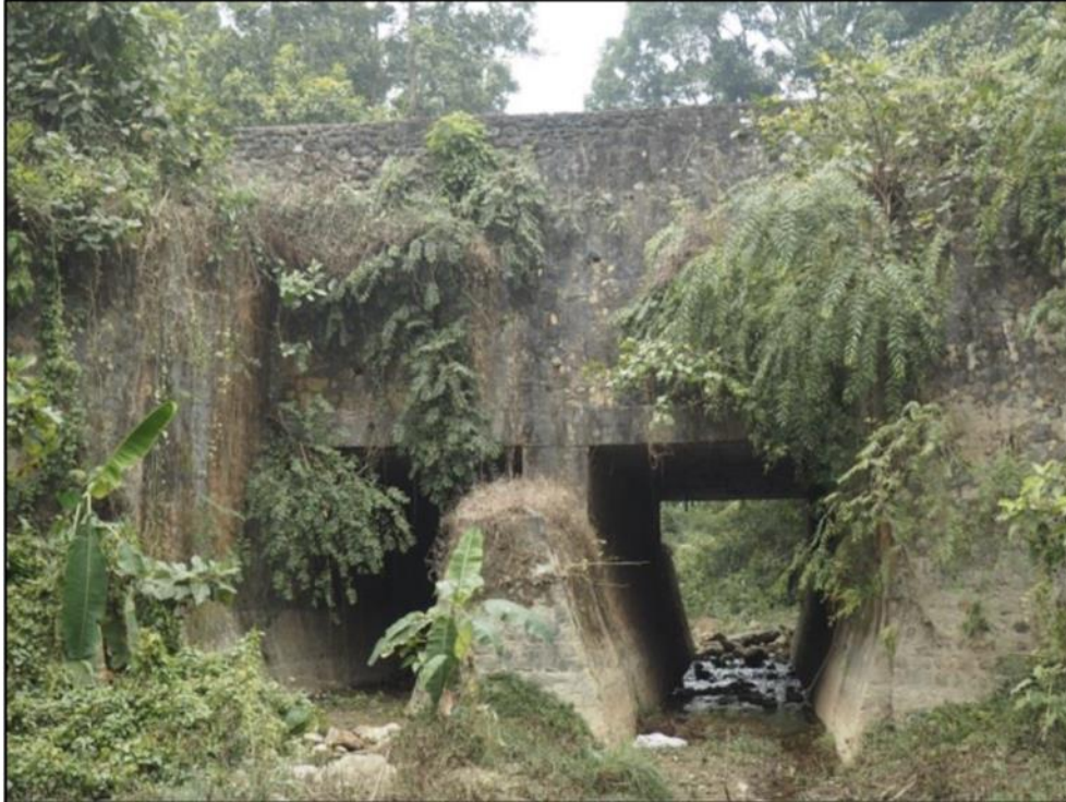
ภาพที่ 19 แสดงสะพานที่มีทางลอดคู่ขนานที่มีอยู่ในปัจจุบันมีศักยภาพเป็นทางผ่านของสัตว์ป่าอย่างจำกัด โครงสร้างนี้มีการวางแผน เพื่อแทนที่ด้วยสะพานรองช่วงเดียวสูง 6 ม. และกว้าง 16 ม. เครดิตแก่ Anthony P Clevenger
