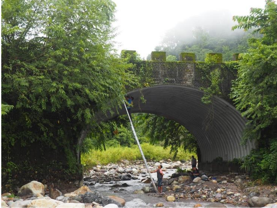
ภาพที่ 7 แสดงทางลอดของสัตว์ป่าที่ออกแบบมาสำหรับทางเดินของช้าง โดยเฉพาะบนถนน NH2 (Raidak-Lhamoizingkha) เกร็ดคิดแก่ Karma Chogyel
