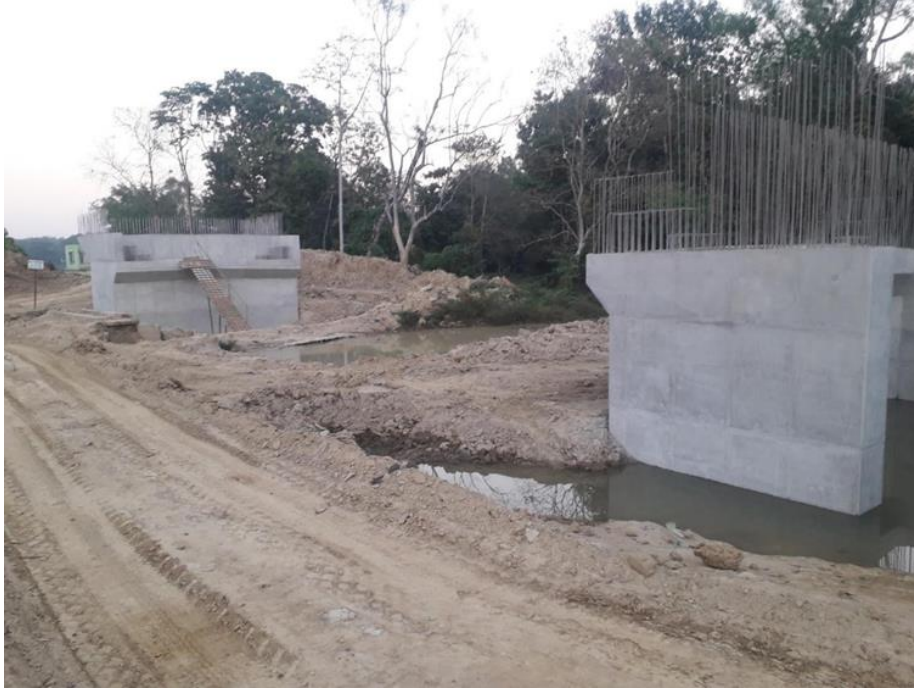
चित्र 4: गिर्डर र Chittagong – कोक्स बजार रेलमार्ग परियोजनामा उत्खनन प्रतीक्षा गरिरहेका वन्यजन्तु अन्डरपासका आधारहरू। अन्तिम आयामहरू: 4.5 मिटरको उचाइ, 30 मिटरको लम्बाइ। क्रेडिट: Asif Imran.
