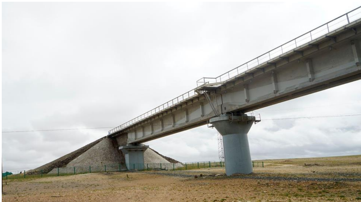
Зураг 14: Вүбэй нүхэн гарцын тусламжтайгаар Төвдийн гөрөөс төмөр замын доогуур аюулгүй гарах нөхцөл бүрдсэн. Төмөр замыг бүхэлд нь хашаалсан нөхцөлд дөрвөн ширхэг нүхэн гарц бол Төвдийн гөрөөс төмөр замыг дайран гарах гол зам юм. Дөрвөн нүхэн гарцаас Вүбэй нүхэн гарцыг Төвдийн гөрөөс илүү ихээр ашигладаг. Талархал: Вэнжин Шу.
