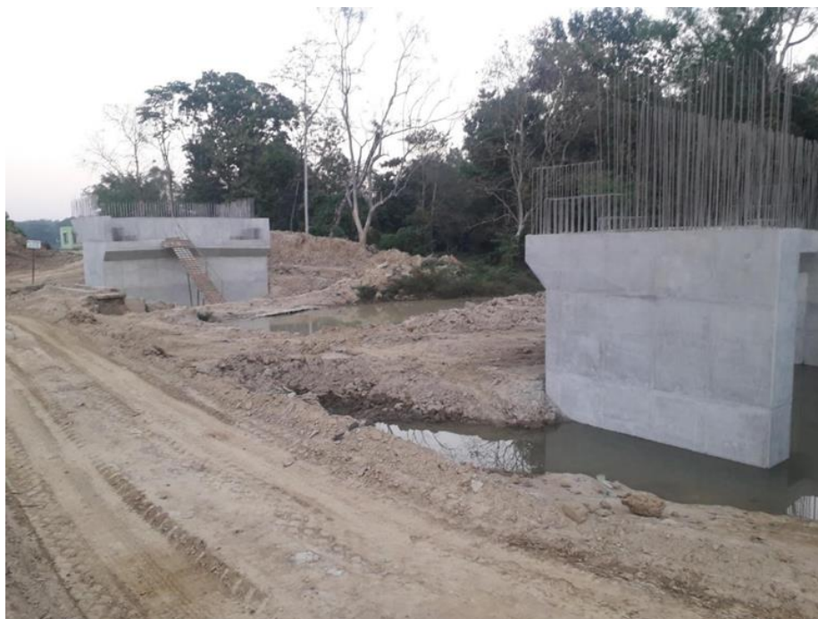
Зураг 4: Бүс хийх, улмаар Читтагонг - Коксын Базаарын төмөр замын төслийн хүрээнд малталт хийхээр хүлээгдэж байгаа зэрлэг амьтанд зориулсан доод түвшний зөрлөгийн багана. Эцсийн хэмжээс: 4,5 метр өндөр, 30 метр урт. Талархал: Асиф Имран.
