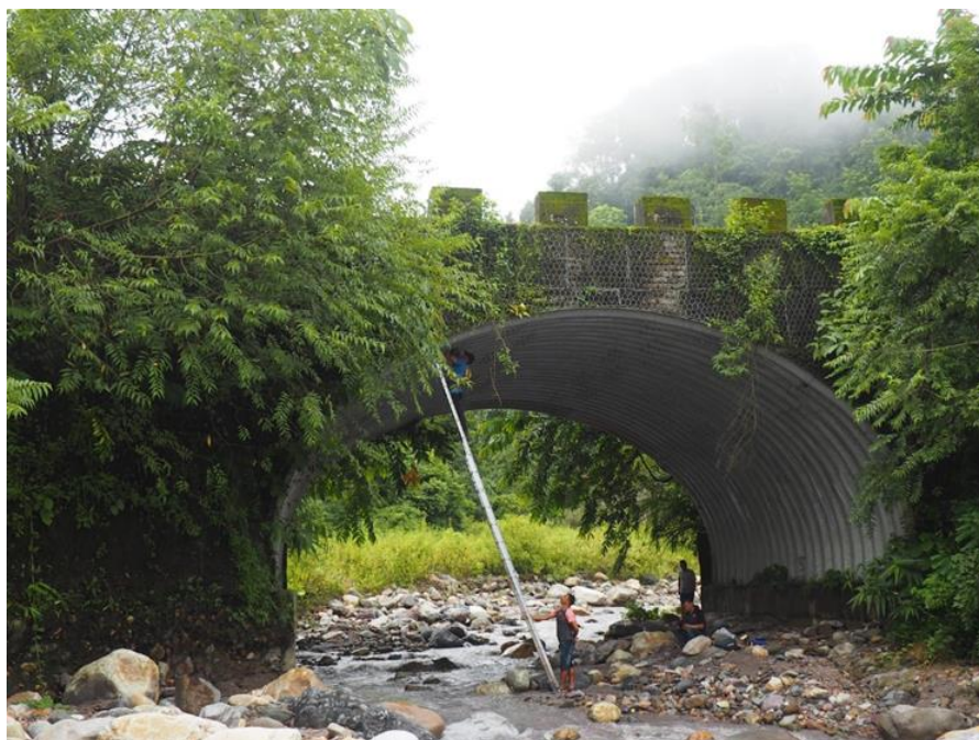
Зураг7: NH2 замд зааны хөдөлгөөнд зориулан байгуулсан замын доогуурх зэрлэг амьтдын гарц (Райдак-Ламойзинка). Талархал: Карма Чойжил.
