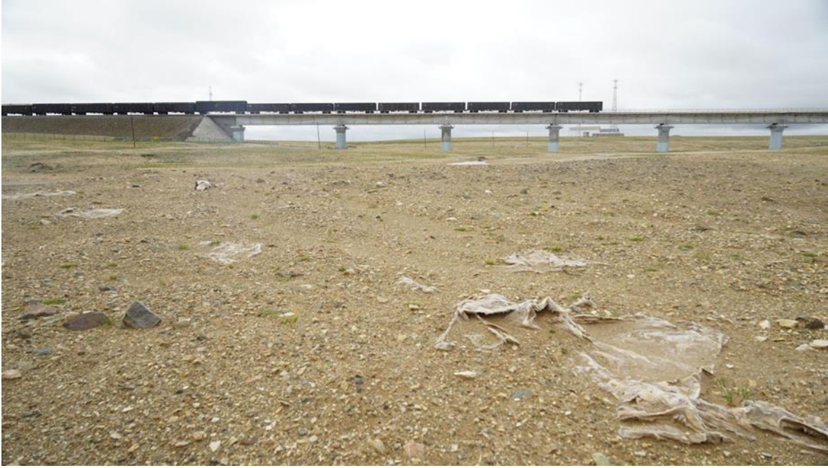
চিত্র।3 : মধ্য চীনে চিংহাই-তিব্বত রেলপথ। তিব্বতি হরিণের দীর্ঘ পথের যাত্রার উপর চিংহাই-তিব্বত রেলপথের সরাসরি প্রভাব রয়েছে। হোহ-শিল এলাকার জন্য উবেই আন্ডারপাস সহ চারটি প্রধান ক্রসিং অবকাঠামো নির্মাণ করা হয়। সূত্র: ওয়েঞ্জিং শু
