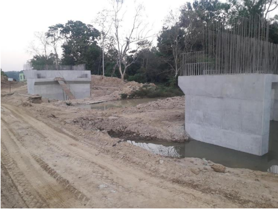
চিত্র 4: গার্ডারের অপেক্ষায় বন্যপ্রাণীর জন্য নির্মিত আন্ডারপাসের মোড় এবং অতঃপর চট্টগ্রাম – কক্সবাজার রেলওয়ে প্রকল্পের খনন কাজ। চূড়ান্ত হিসাব: 4.5-মি লম্বা, 30-মি দৈর্ঘ্য সূত্র: আসিফ ইমরান
