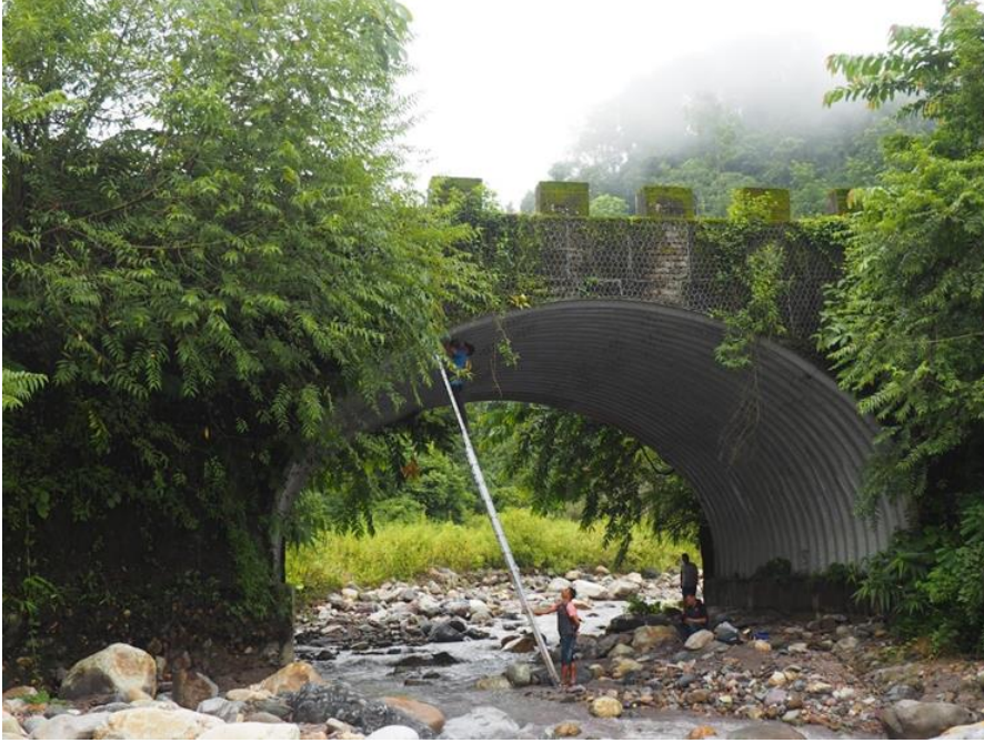
চিত্র 7: NH2 সড়কে হাতির চলাচলের জন্য ডিজাইনকৃত আন্ডারপাস (রাইদাক-লামইজিংখা) সূত্র: কারমা চগয়েল
