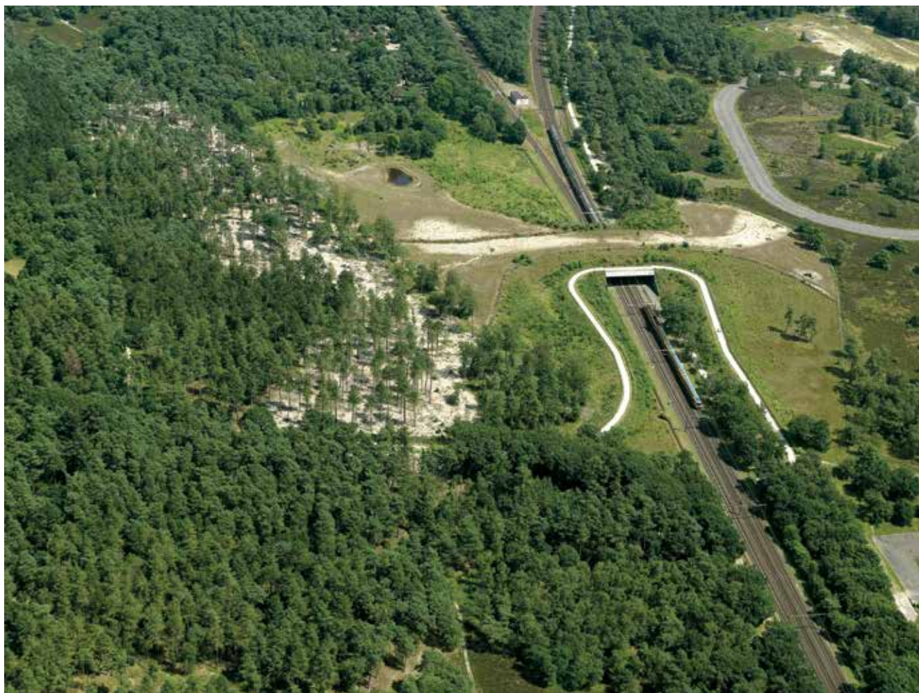
Figure 2. Ecoduct Op Hees au-dessus de la ligne ferroviaire Utrecht-Amersfoort. La piste cyclable est située en avant-plan du passage. © ProRail
