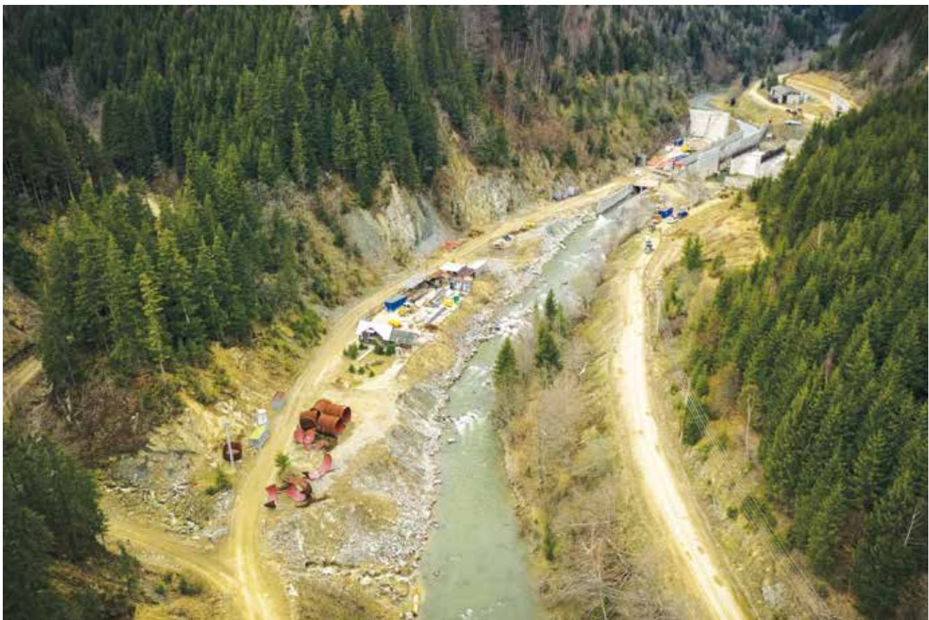
Seulement un tiers des fleuves et des rivières du monde ne sont pas aménagés. Les barrages sont le principal obstacle à la connectivité dans les milieux d'eau douce. La photo montre un barrage en construction sur la célèbre rivière Bâsca Mare, en Roumanie, au cœur de l'écorégion des Carpates en Europe. © Leeway Collective / Balkan River Defence, Avec l'aimable autorisation de Calin Dejeu
